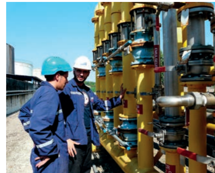
Formation par compagnonnage sur le système de défense incendie
