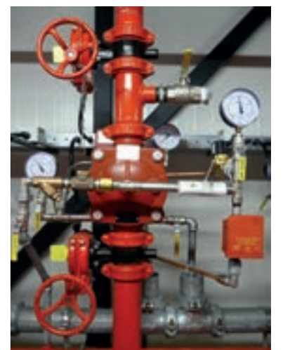
Vannes du système d'incendie
